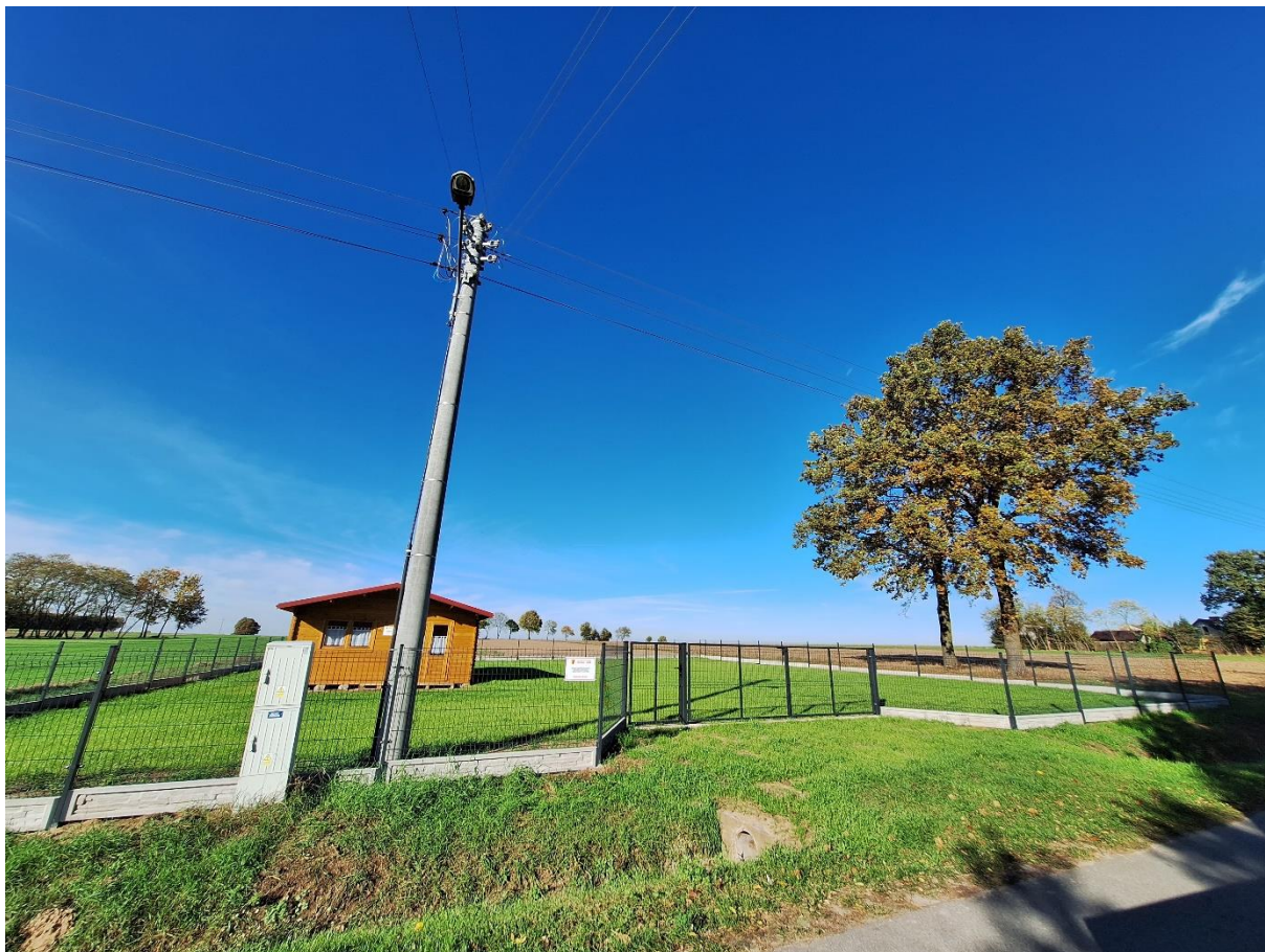
Rysunek 6. Zakup i montaż ogrodzenia placu rekreacyjnego w sołectwie Piaski
