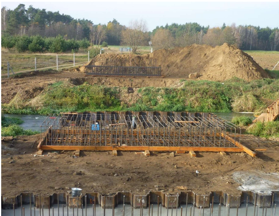
Rysunek 4. Budowa Kładki na rzece Oleśnica w miejscowości Mała Wieś
