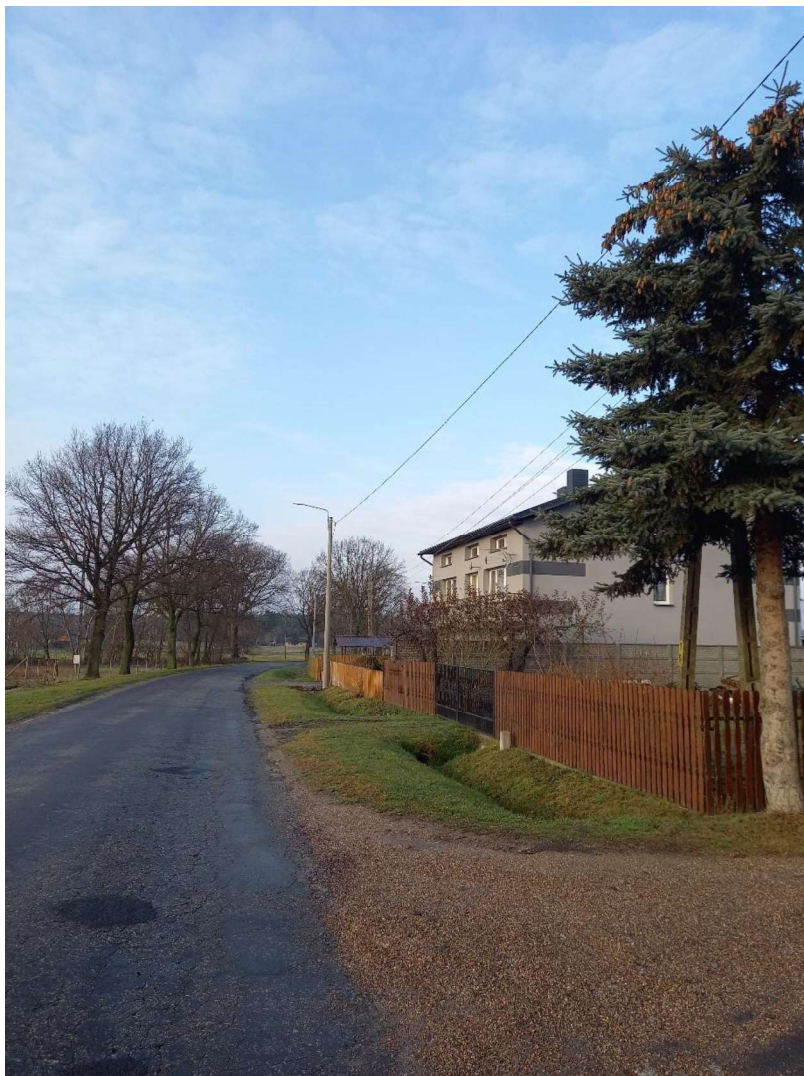
Rysunek 5. Oświetlenie uliczne w miejscowości Szynkielów Źródło: Opracowanie własne.
