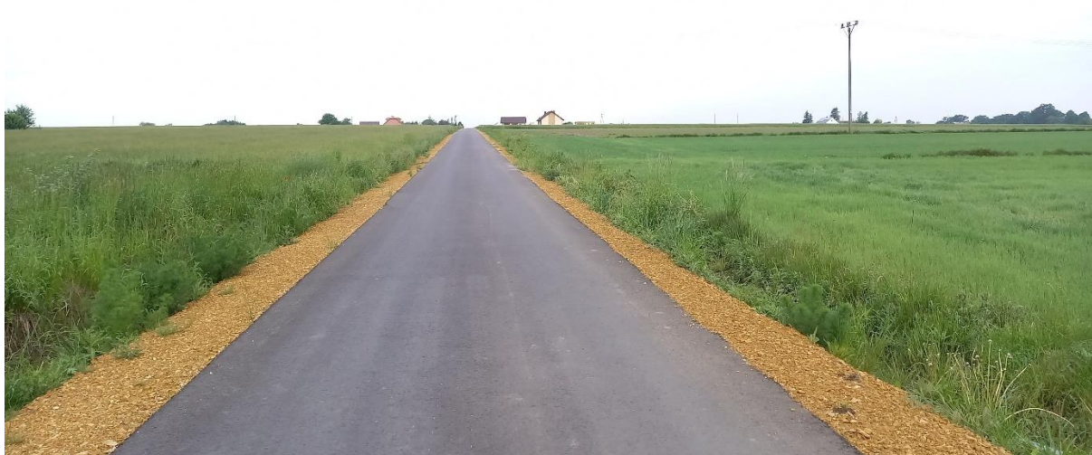
Rysunek 7. Remont drogi gminnej Szynkielów -Kolonia Majorat
