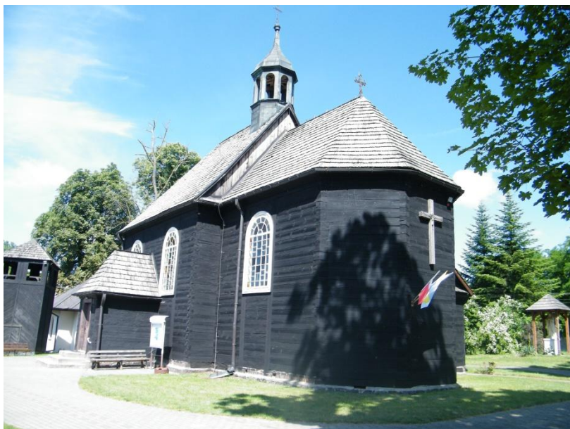
Rysunek 15. Podobszar rewitalizacji Rychłocice. Budynek – drewniany kościół w Rychłolicach
