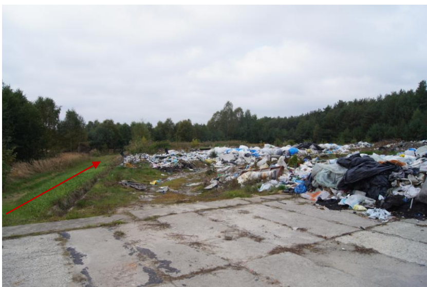
Fot 2. Kwaterna składowania, widoczny rów odprowadzenia wód opadowych i (oznaczona) droga dojazdowa do przyszłego zbiornika odcieków.
